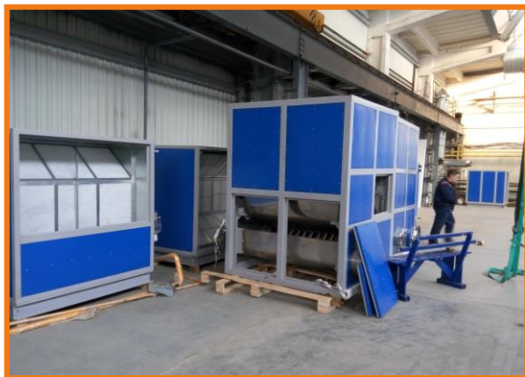
Установка съемных панелей 50 мм из минваты
