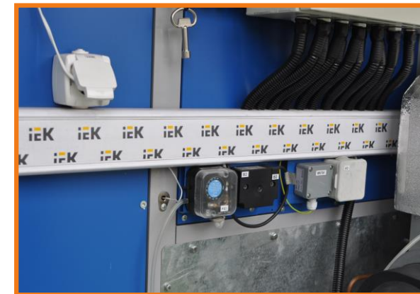
Разводка электрики шкафов и датчиков
